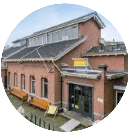
Het Gemaal op Zuid
